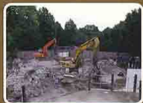
解体中のゾウ舎
