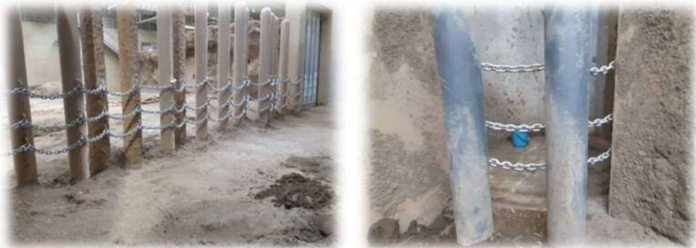
30 cm間隔で溶接したフックにチェーンを取り付け
