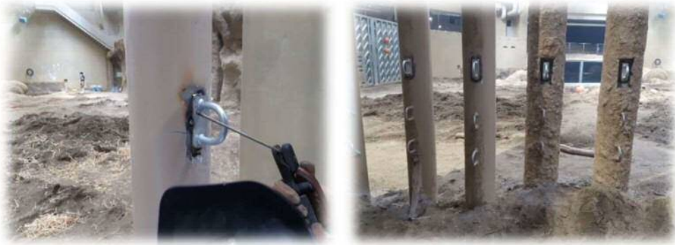
ゾウに壊されないように頑丈な金具を溶接
