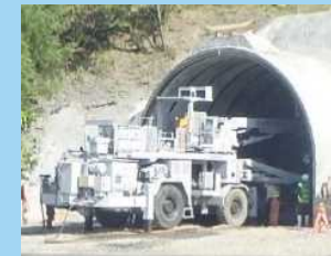
札幌トンネル(星置工区)
