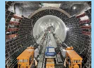
札幌トンネル(札幌工区)
