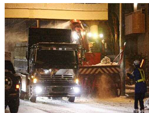
排雪作業状況
