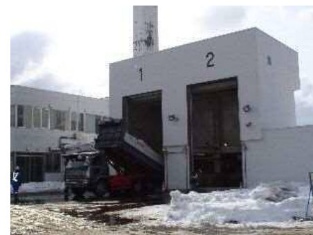
新川融雪槽の能力増強(工事中)
