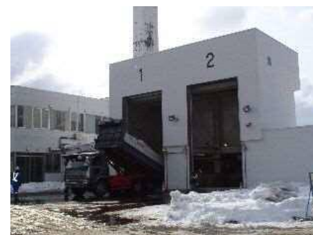
新川融雪槽の能力増強(工事中)
