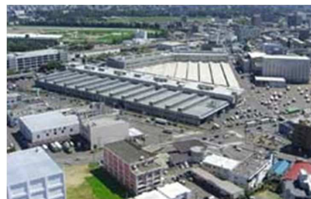
<市有施設への太陽光発電設備設置実績>
