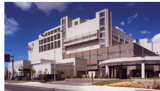
※写真はイメージ(現白石清掃工場)
