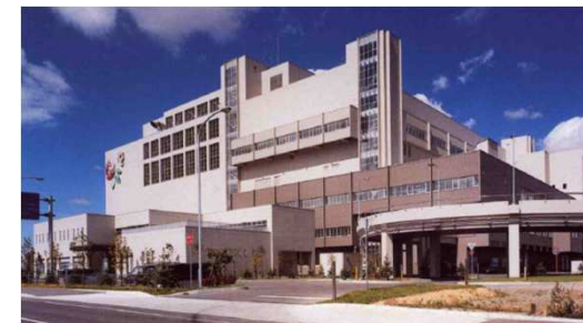
※写真はイメージ(現白石清掃工場)
