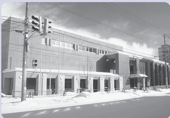
住民の意見を取り入れて建設された西区・はちけん地区センター
