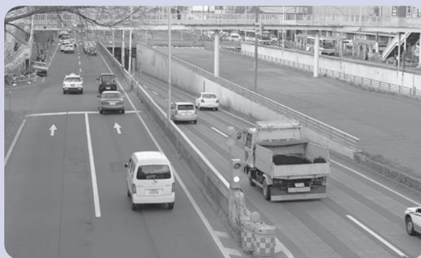
工事着工前(17年11月)のアンダーパス
