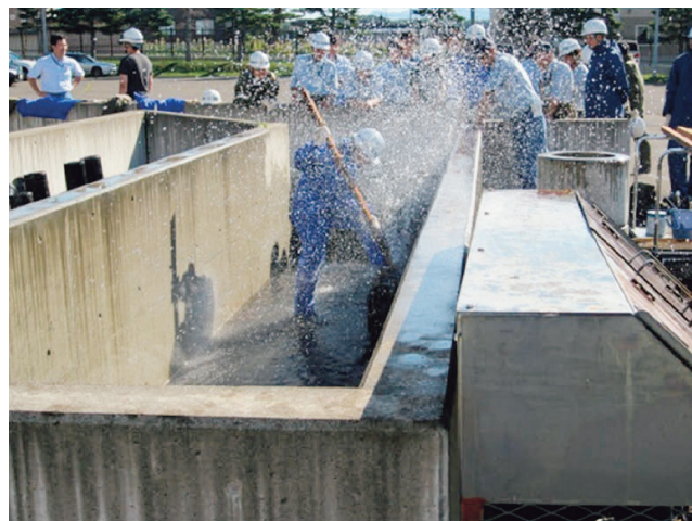
漏水修理実習
