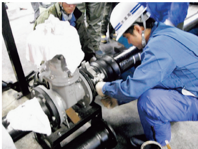
配水管接合実習
