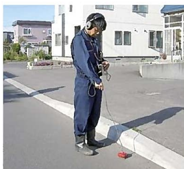
漏水探知器による調査
