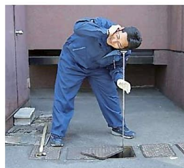
水道メーターの音聴調査
