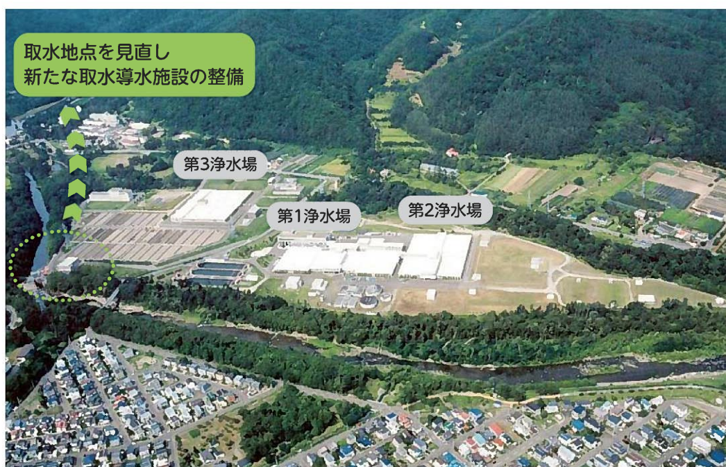
【図表30】白川浄水場の全景
