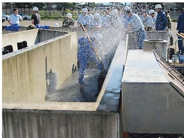
漏水修理実習
