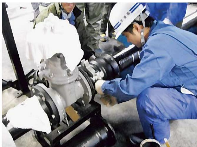
配水管接合実習
