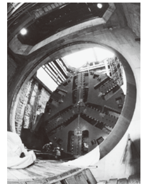
1988年(昭和63年)12月2日 東豊線開業に伴い東西線と東豊線車両の乗り入れトンネルにシールド工法が採用された
