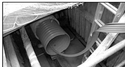
管更生工法による老朽管の改築
