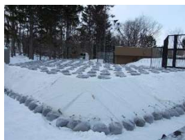
遮熱シートによる簡易型貯蔵プール
