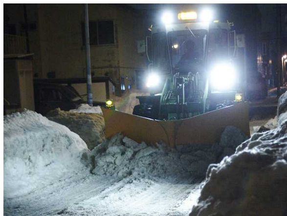
路面整正の作業状況
