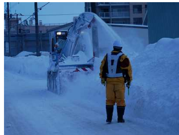
拡幅除雪の作業状況
