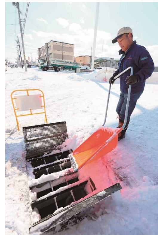
流雪溝に投雪している様子
