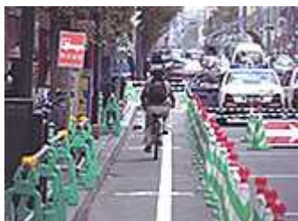
自転車走行区間の設置
