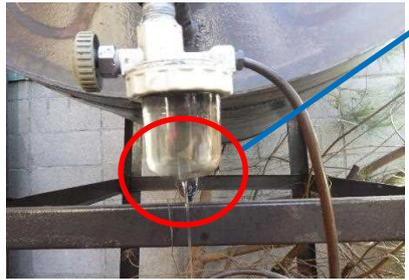
ストレーナー(ろ過装置)が老朽化によりひび割れ、下部から灯油が流出している。
