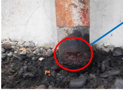
土中に近い部分の配管が腐食し、灯油が漏えいした。
