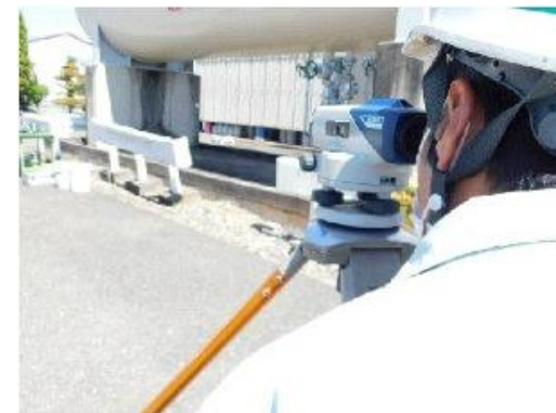
貯槽の沈下状況測定
