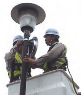
寄贈したソーラー式電波時計を自ら東区の公園に設置している様子
