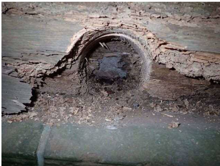
土台1 (玄関付近)
