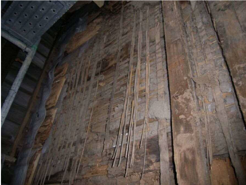
2014年外部改修工事の状況写真
