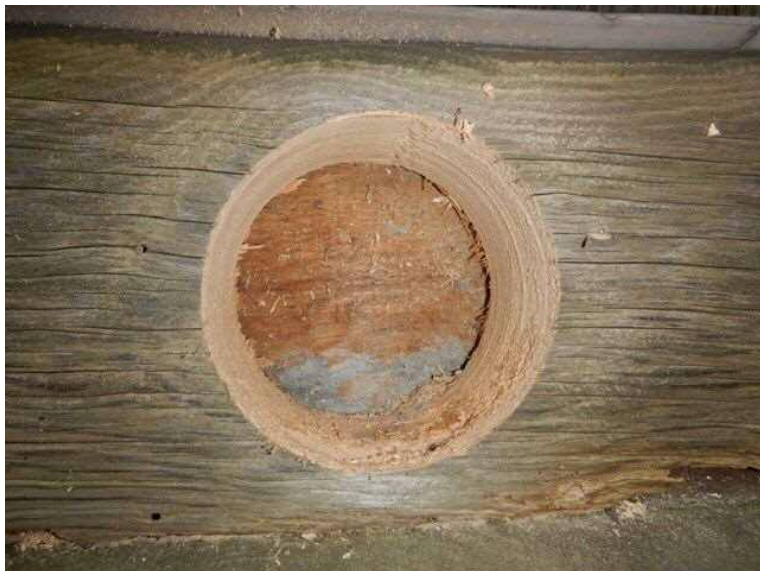
土台2 (和室付近)
