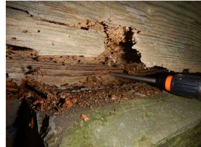
土台の腐朽
