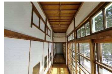
旧三菱鉱業寮の二重窓
