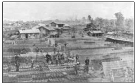
鈴木煉瓦製造場の干場(明治19年) 出典：白石区役所HP(白石歴しるべ)
