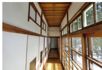
旧三菱鉱業寮の二重窓
