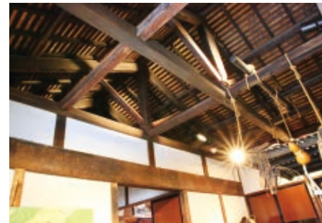
旧棟の天井を見上げると、キングポスト・トラスの構造がよく分かる。
