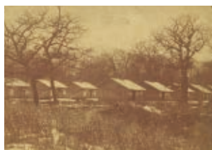
建坪17.5坪、茅葺き土壁の兵屋が並ぶ琴似屯田兵村の様子。(写真所蔵/北海道大学附属図書館)
