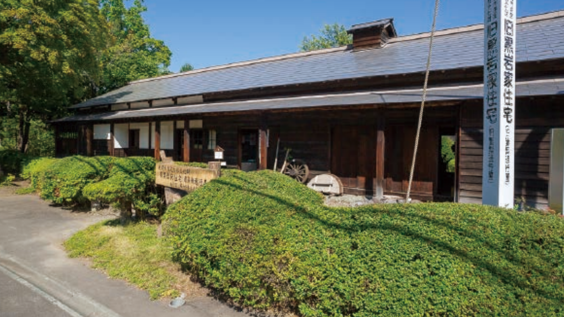
建物は北海道遺産「開拓時代の洋風建築」のひとつにも選定されている。
