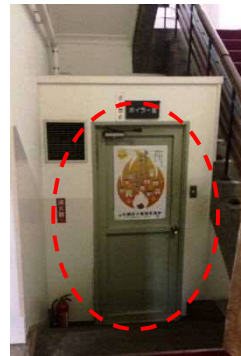
創建時は無かった ボイラー室
