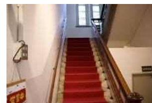
人造石研ぎ出し階段と鍛金手すり
