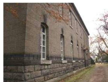
南側側面外観
