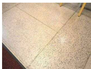
人造石研ぎ出し 仕上げ床材・真鍮目地
