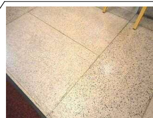
人造石研ぎ出し仕上げ 床材と真鍮目地
