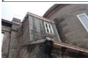
増築部 (モルタル)
