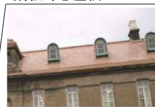
鋼板葺き屋根
