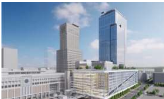
（仮称）札幌駅交流拠点北 5 西 1・西 2 地区 第一種市街地再開発事業（令和 10 年秋竣工予定） 出典：準備組合提供
