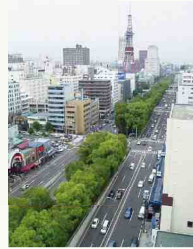
創成川公園整備前
