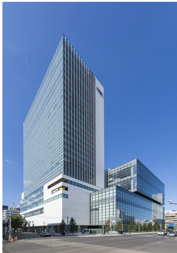
札幌創世 1.1.1 区北 1 西 1 地区（平成 30 年 5 月竣工）
