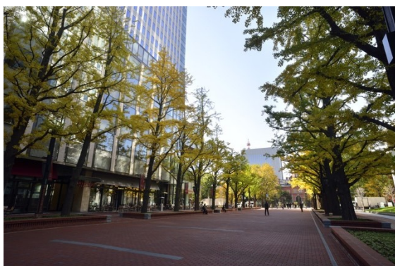
札幌三井 JP ビル（平成 26 年 8 月竣工）
