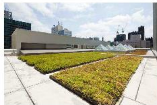
断熱性能に寄与する屋上緑化
