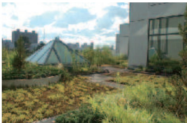
厚別区役所の屋上緑化
