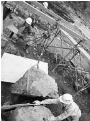
写真2：割ったブロックを、機械でつり上げて採取。
