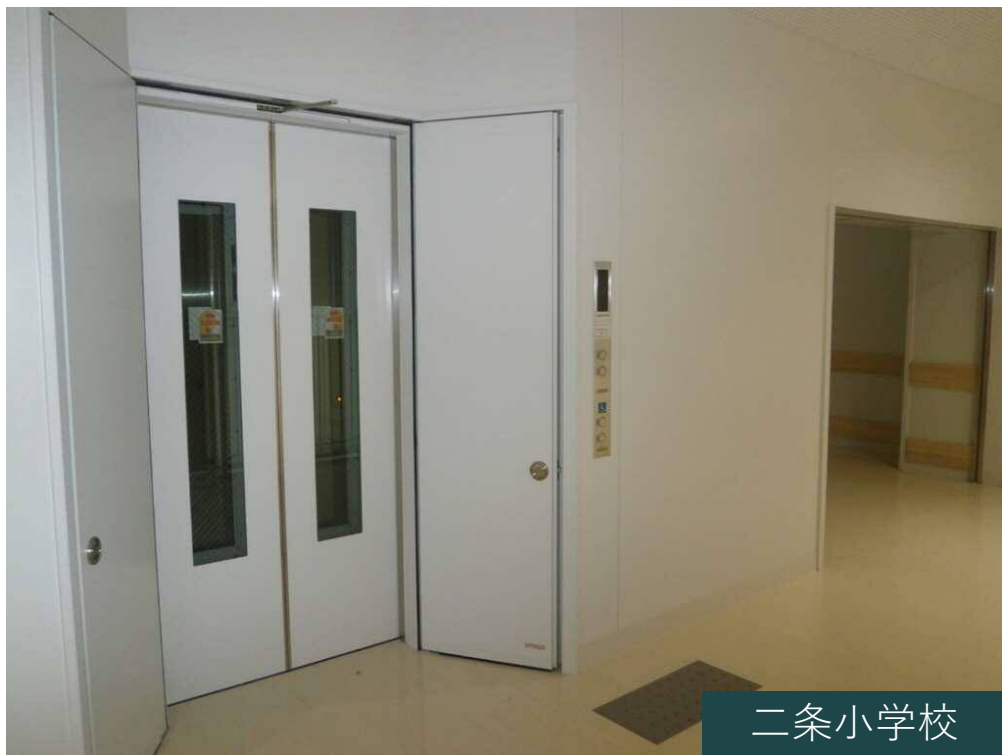
エレベーター
