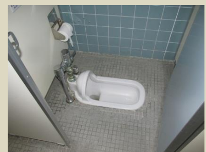
床がタイル敷きの和式便器
