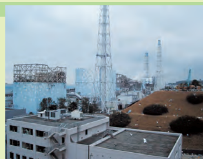
福島第一原子力発電所 1～4号機 (2011年3月15日撮影：提供 東京電力)
