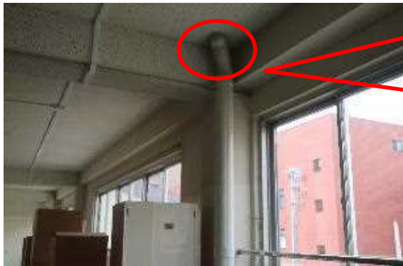
② 渡り廊下(屋内運動場側)配管エルボ部 保温材
