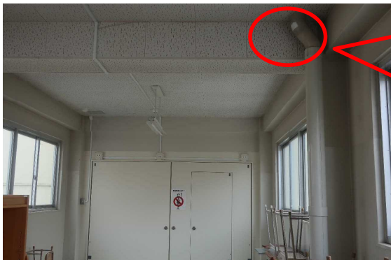
② 渡り廊下(屋内運動場側)配管エルボ部 保温材
