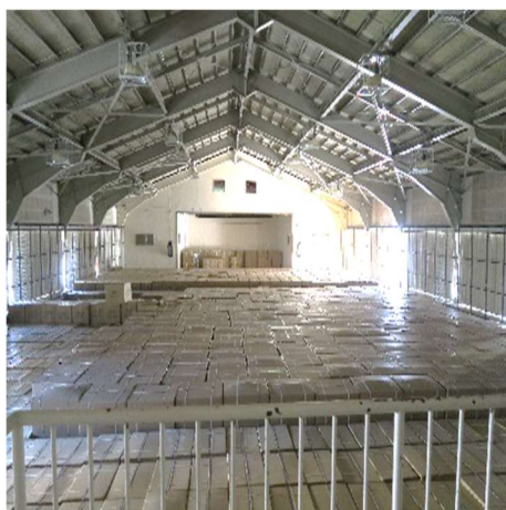
豊水拠点倉庫
