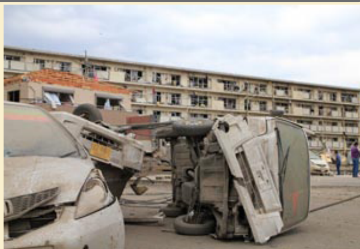
* 丈夫な建物の被害例（つくば市提供）
