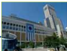
都心の拠点開発に合わせ、エネルギーセンターの整備を進めてきています。
