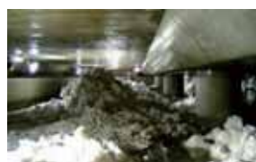
融雪槽の雪を冷水熱源に利用 (札幌駅北口地区)
