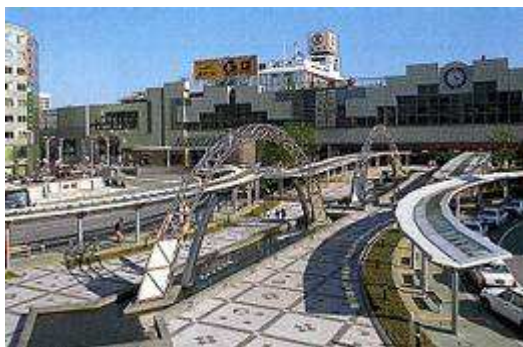
▼札幌駅北口駅前広場
