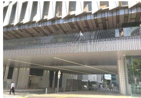
街区を横断した道路上空利用のイメージ 梅田一丁目一番地（大阪市）
