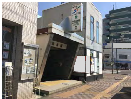
中島公園駅2番出入口
