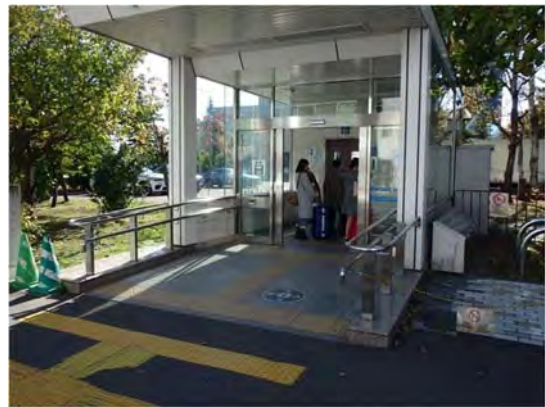
中島公園駅1番出入口エレベーター
