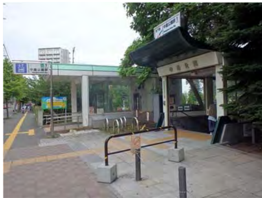
中島公園駅1番出入口
