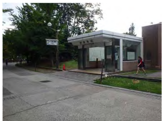
中島公園駅3番出入口
