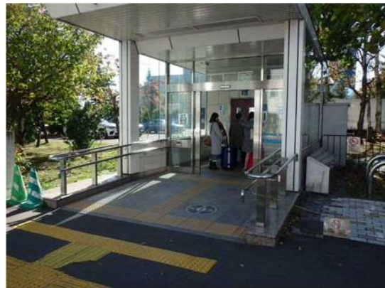
中島公園駅1番出入口エレベーター
