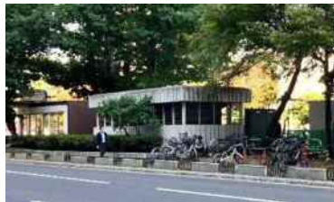
西10丁目 通気口（公園南側）
