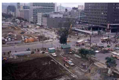
建設中の地下街（1971年10月撮影） 出典：札幌市公文書館所蔵
