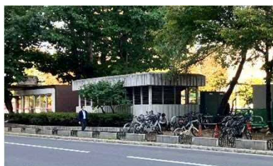
西10丁目 通気口 (公園南側)
