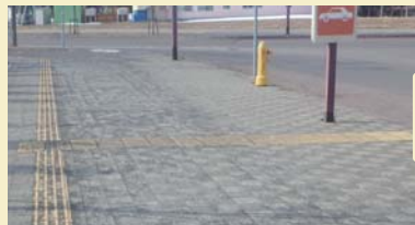
清掃前の状況
